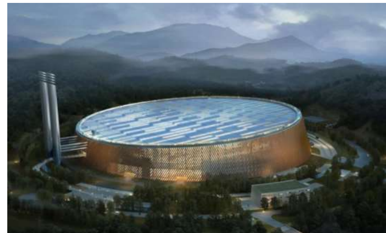
Verdens største avfallsforbrenningsanlegg bygges i Shenzhen. Kapasiteten er ca 1.8 mill tonn avfall årlig. Til sammenligning: forbrenningskapasiteten i Norge var 1.7 mill tonn i 2014***
